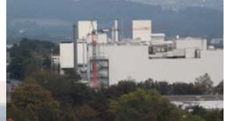
Firma Axalta Neubau
