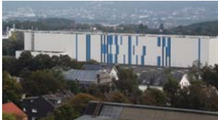
Firma Axalta Fertiglager (Hatzfelder Klagemauer)
